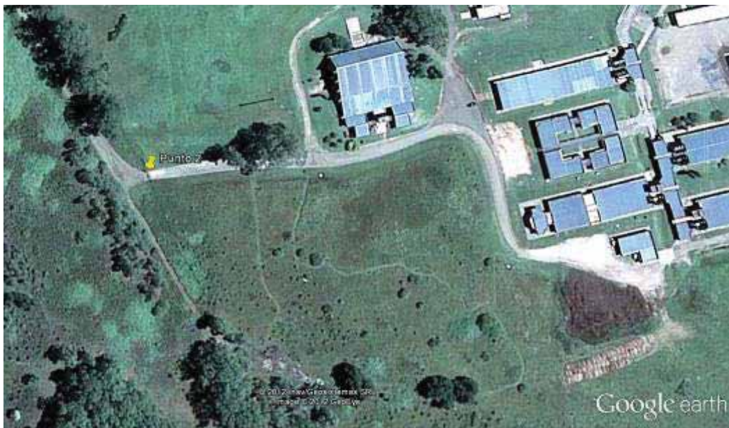
Figura 30. Punto 2 en el portón de salida en cercanías del gimnasio.
